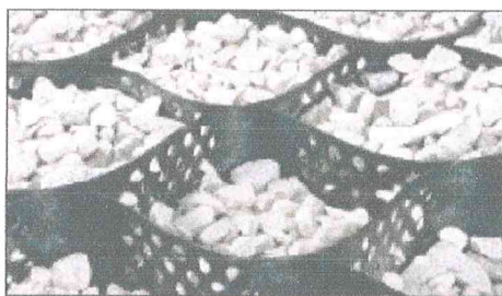
Rys. 6. Zasypywanie kruszywem komórek geosiatki za pomocą równiarki
