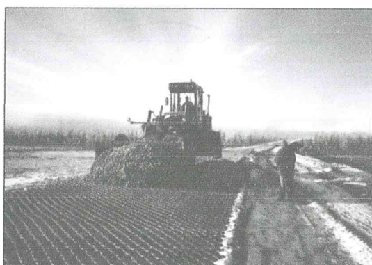
Rys. 7. Podbudowa nawierzchni drogowej wykonana przy użyciu geosiatki komórkowej
