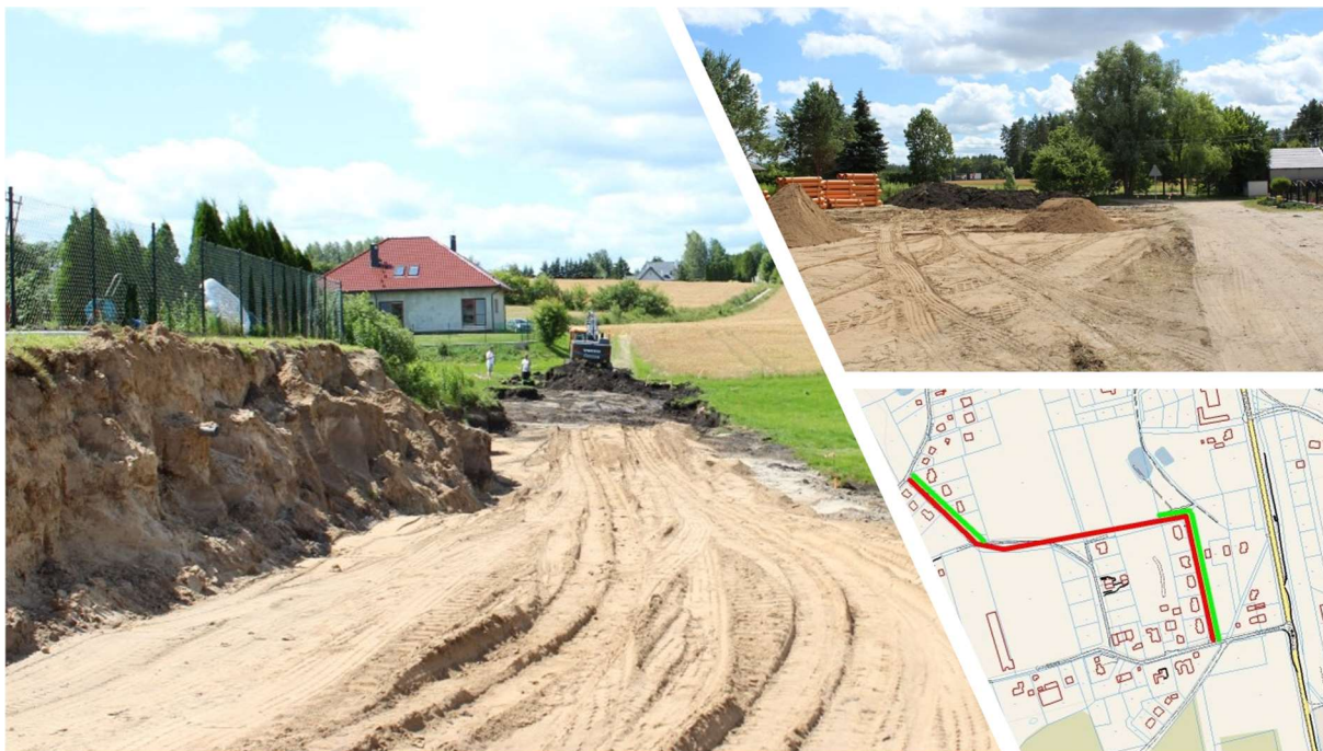
Rysunek 86. Fotorelacja z prac realizowanych w ramach przebudowy ulicy Grzybowej w Dywitach wraz z wizualizacją (źródło: materiały własne Gminy Dywity).
