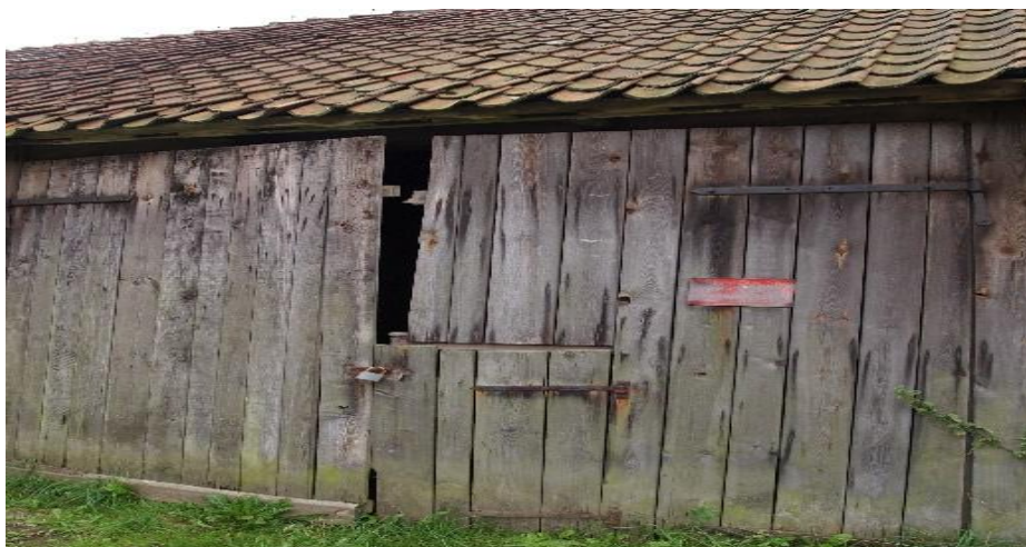
Budynek Stodoły przed rozpoczęciem prac
