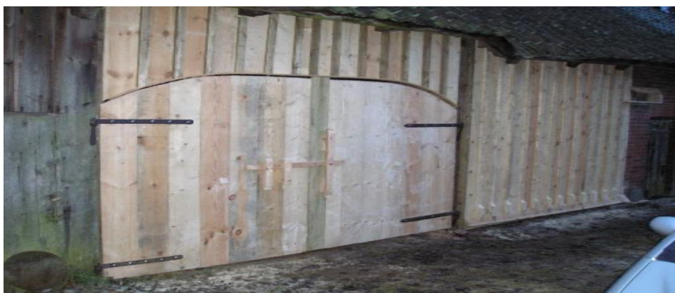
Budynek Stodoły w trakcie renowacji
