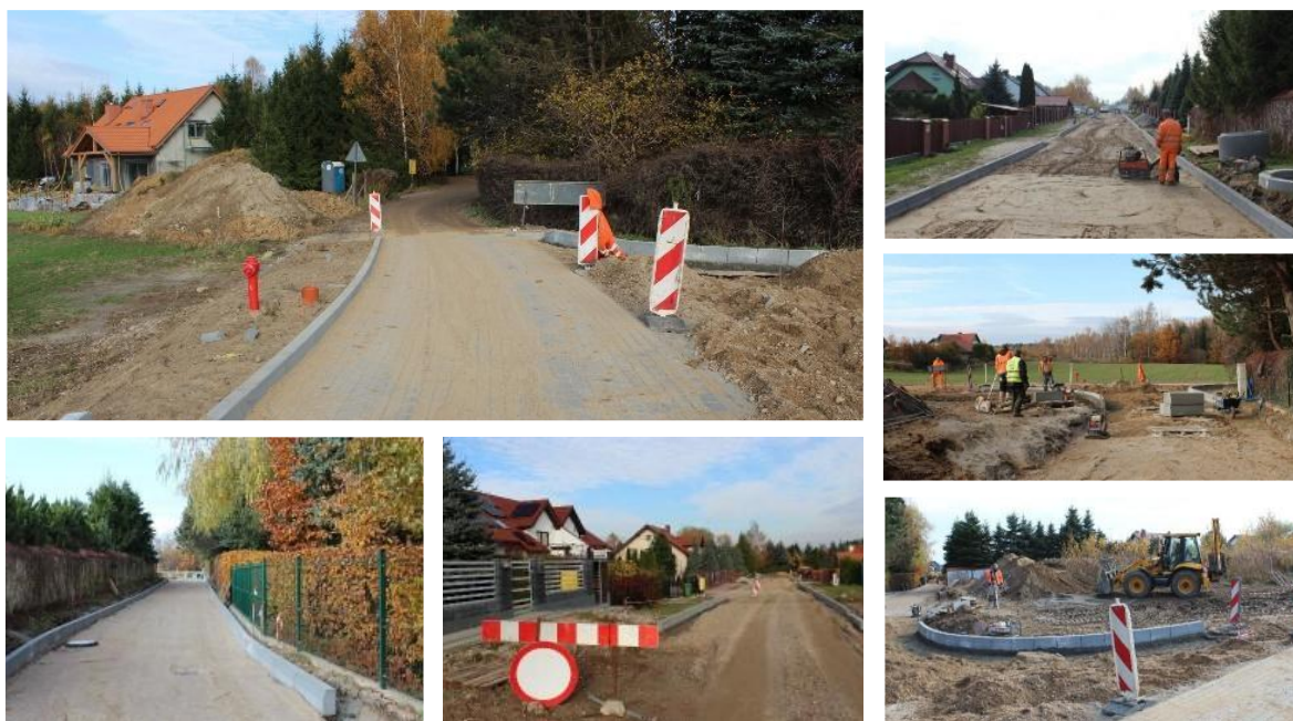
Rysunek 30. Fotorelacja - realizacja inwestycji „budowa dróg na osiedlu za Cefarmem w Dywitach”.
