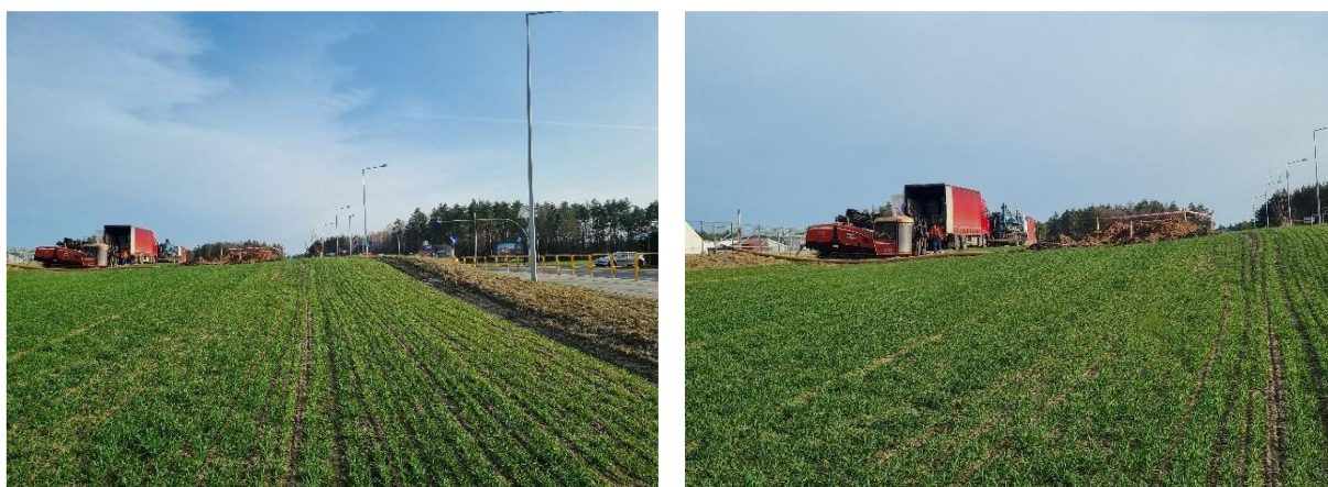
Rysunek 33. Fotorelacja - realizacja inwestycji „budowa sieci kanalizacji sanitarnej i wodociągowej w Dywitach”.
