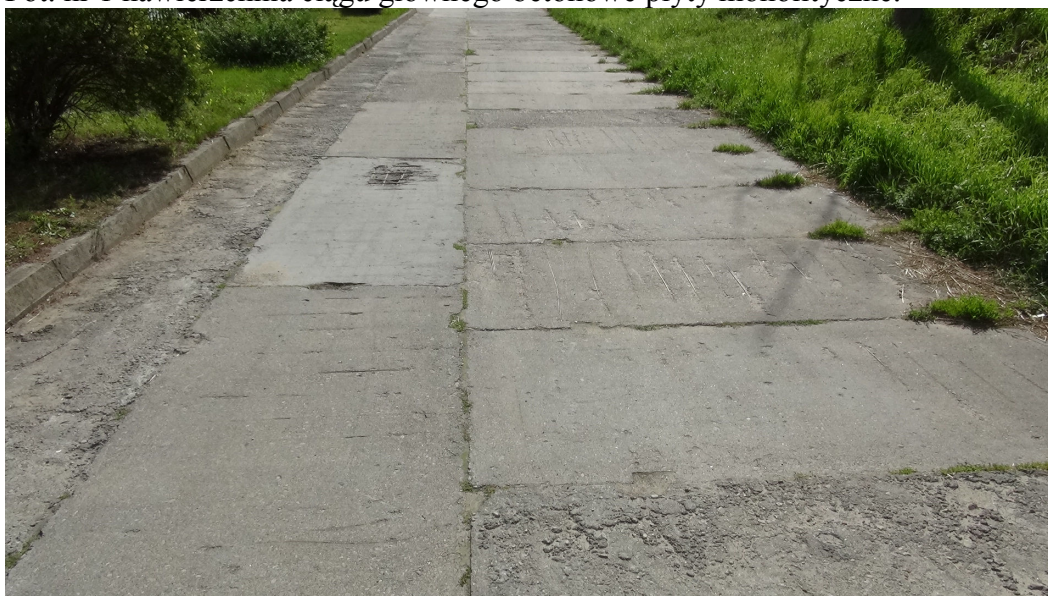
Fot. Nr 2 nawierzchnia dojazdu do działek nr 67-59 betonowe płyty prefabrykowane
