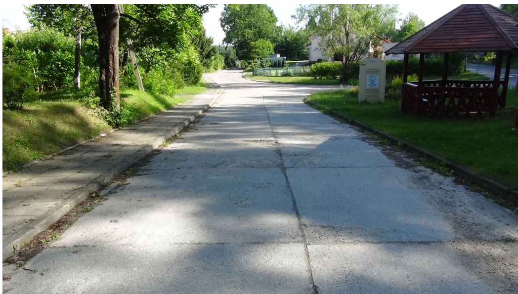
Fot. nr 1 nawierzchnia ciągu głównego betonowe płyty monolityczne.
