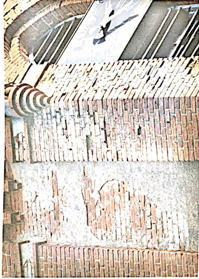
Widok zniszczonego tynku na wieży.
