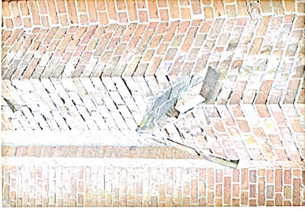
Widok zniszczeń na szkarpie wywołanych wypłukiwaniem soli
