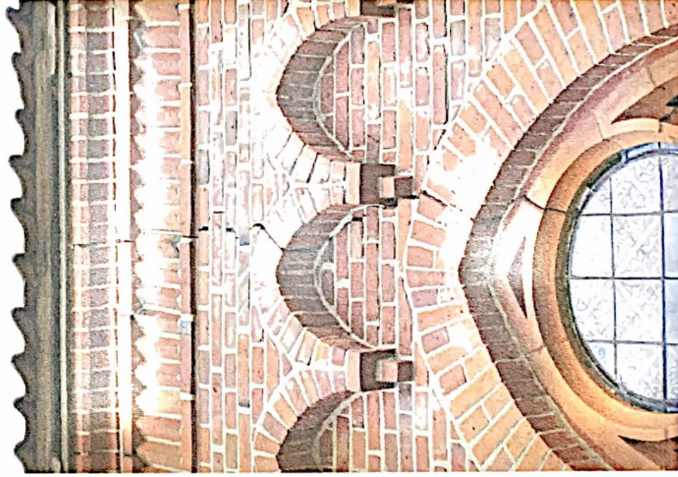
Widok pęknięcia w nadprożu okna
