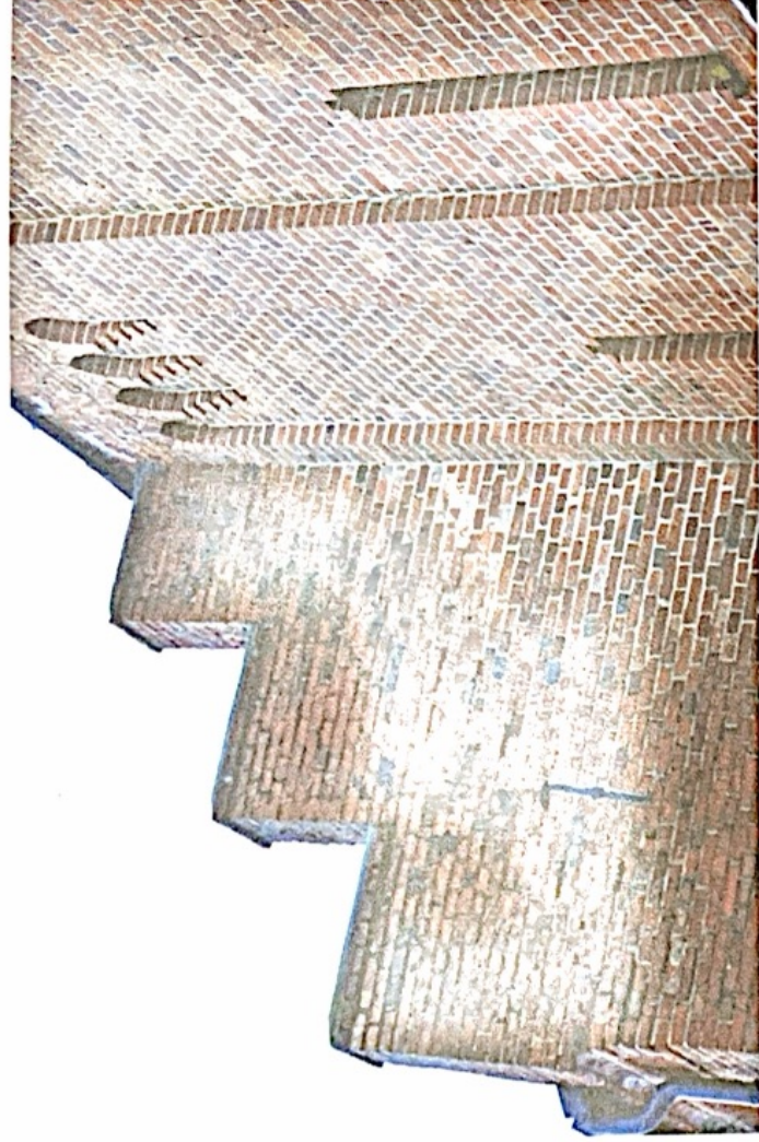
Fragment bocznego szczytu nawy od strony północnej, silne zawilgocenie i nawarstwienia glonów
