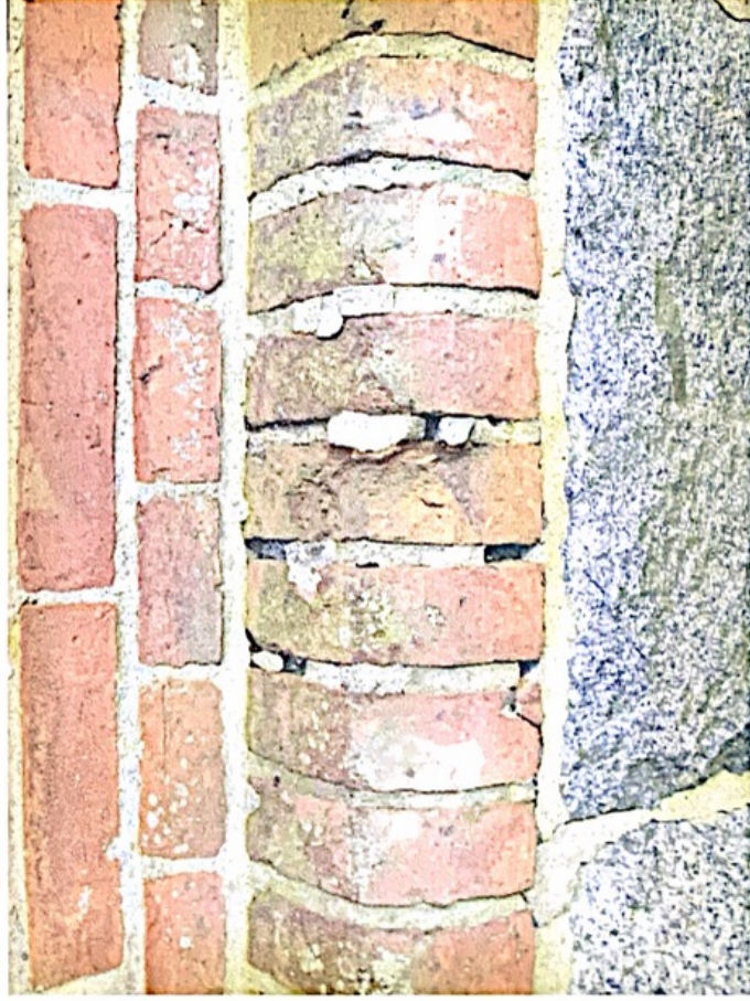
Widok zniszczeń na szkarpie wywołanych wypłukiwaniem soli
