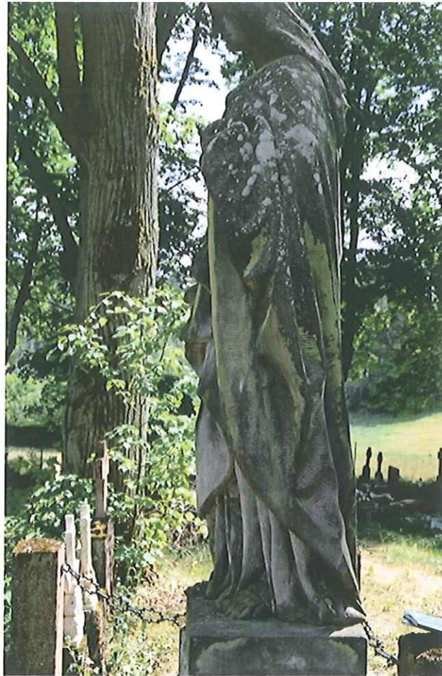
15. Pomnik z figurą Matki Boskiej. Stan obecny. Widok od tyłu. Widoczna powierzchnia rzeźby pokryta nawarstwieniami kolonii porostów i glonów.
