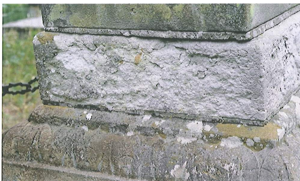
20. W partii cokołu widoczne zniszczenia strukturalne płyty postumentu.
