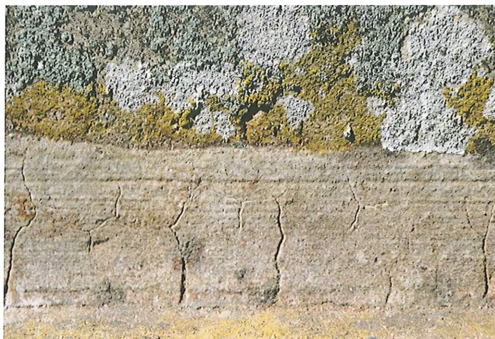
25. Widoczne spękania spoinowania.
