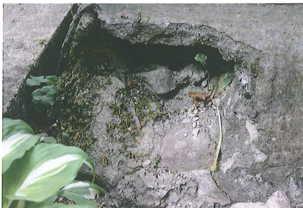
23- 24. Partia zniszczonej podmurówki – detal.
