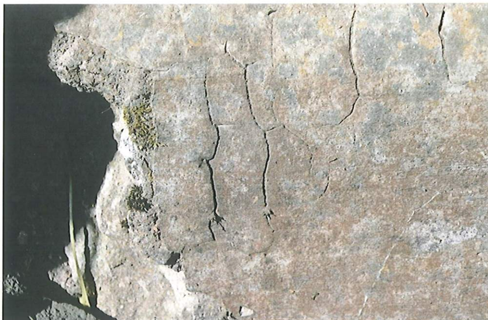
27. Podmurówka – widoczne spękania wyprawy na podmurówce
