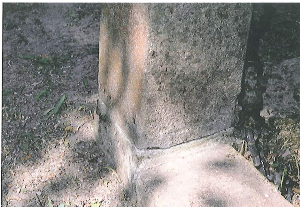
54. Ogrodzenie – fragment. Widoczne spękania i rozwarstwienia.
