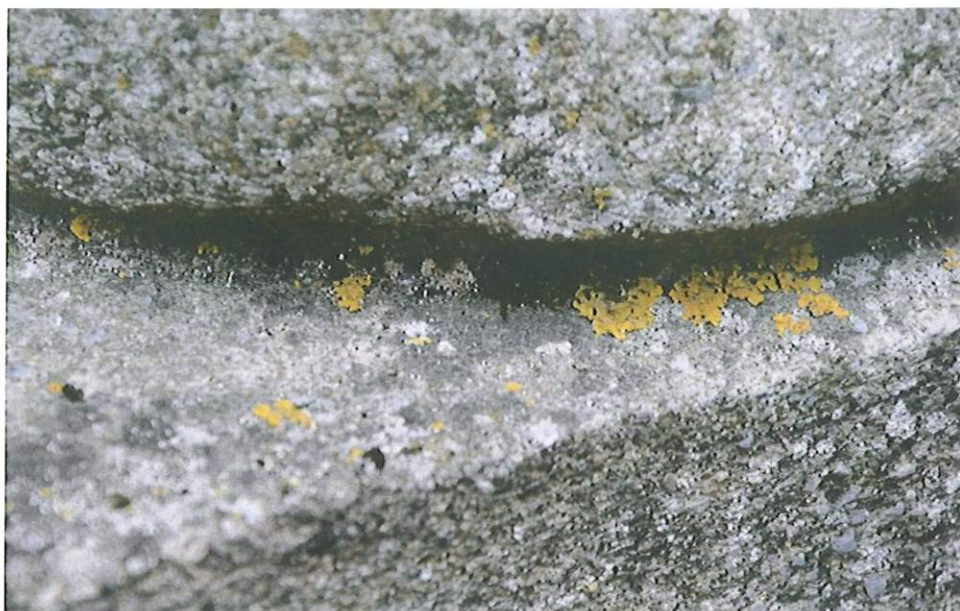
43. Zbliżenie fragmentu płaszcza – widoczny ubytek i pęknięcie formy oraz kolonie glonów.
