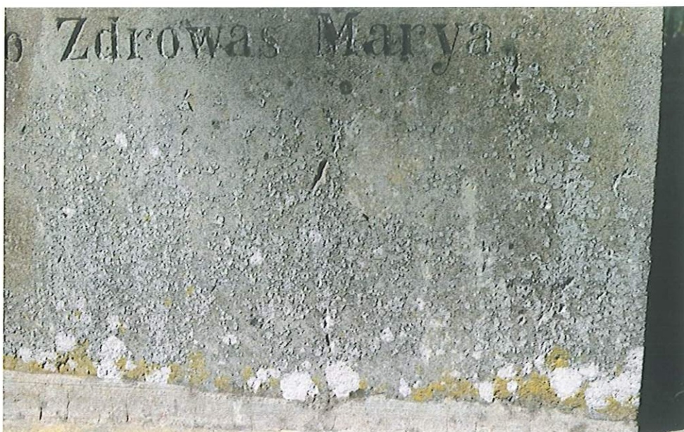
19. Widoczne zniszczenia powierzchni kamienia.
