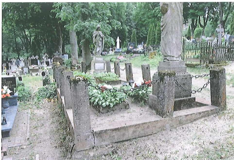
8. Aktualny stan zachowania. Widoczne spękania podwaliny ogrodzenia i pochylenie obiektów w stronę stoku.
