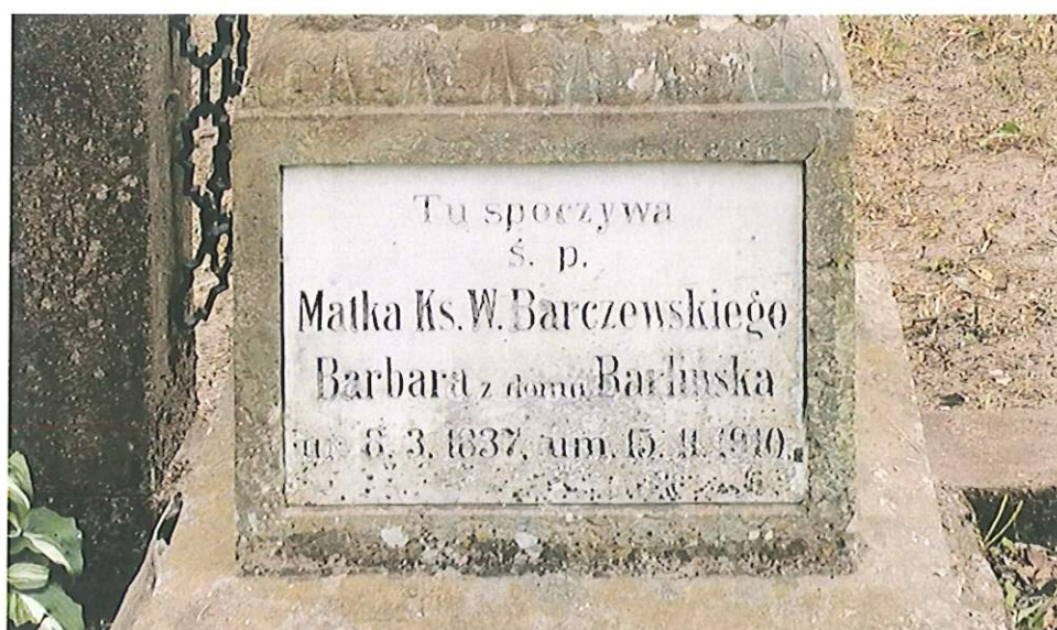
16. Stan zachowania inskrypcji na tablicy frontowej. W partii cokołu widoczny zdegradowany, prawie nieczytelny rysunek reliefu (kimationu).
