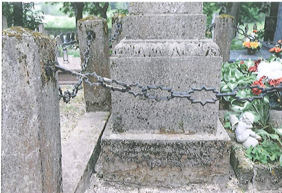
39. Cokół - widoczne spękania i odspojenia w dolnej partii.
