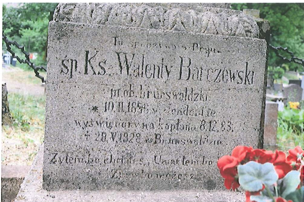
38. Cokół z inskrypcją poświęconą ks. Walentemu Barczewskiemu. Widoczny stan zachowania i zawilgocenie dolnej partii cokółu.
