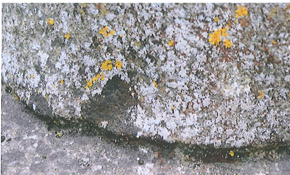
44. ,Zbliżenie fragmentu płaszcza– widoczny ubytek i pęknięcie formy.
