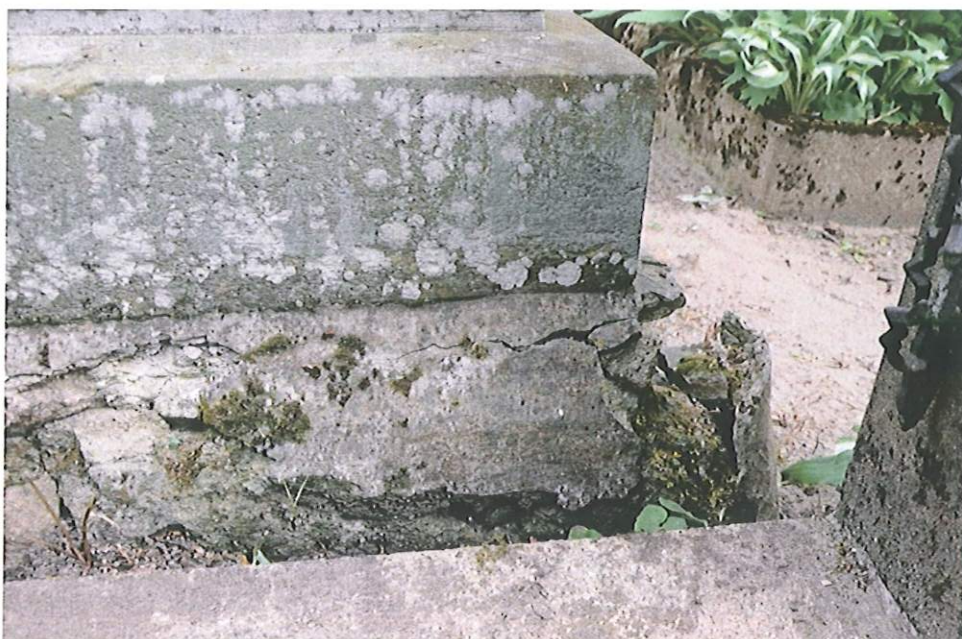
22. Stan zachowania podmurówki – ubytki i rozwarstwienia świadczące o wadliwie wykonanych naprawach i o parciu gruntu.
