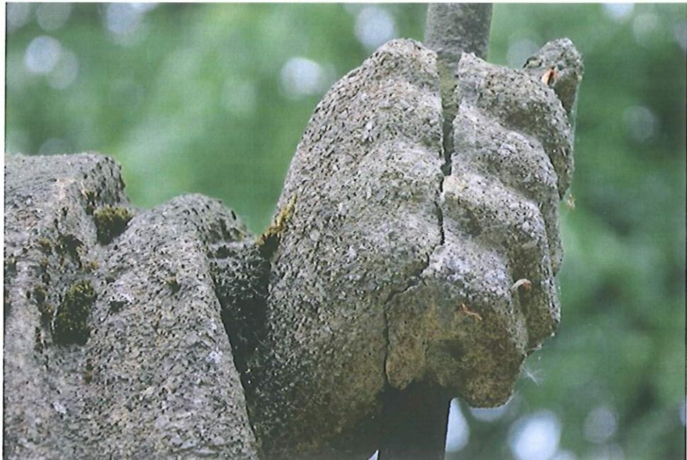
37. Widoczny ubytek, spękania i rozwarstwienie formy.
