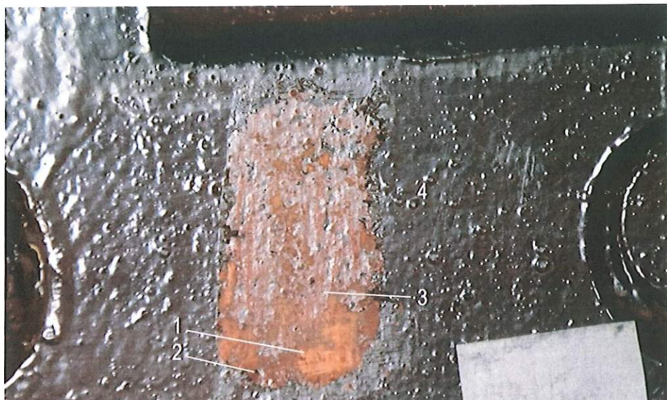
16. Głowica słupa (pkt 3). Widoczna stratygrafia warstw: 1-drewno, 2-warstwa malarska czerwono-brązowa, 3- warstwa malarska siena palona, 4- warstwa malarska umbra palona.
