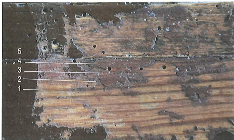
18. Pulpit ławki (pkt 5). Widoczne otwory wylotowe drewnojadów. Stratygrafia nawarstwień: 1-drewno, 2-warstwa malarska czerwono-brązowa, 3- warstwa czerwono-brązowa jasna, 4- warstwa malarska siena palona, 5-warstwa malarska umbra palona.
