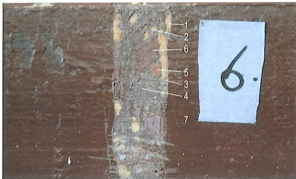
19. Oparcie ławki (pkt 6). Widoczna stratygrafia nawarstwień: 1-drewno, 2-warstwa malarska czerwono-brązowa, 3- warstwa malarska jasnoszara, 4- warstwa malarska ciemnoszara, 5- warstwa malarska pomarańczowa, 6 - warstwa malarska siena palona, 7-warstwa malarska umbra palona.
