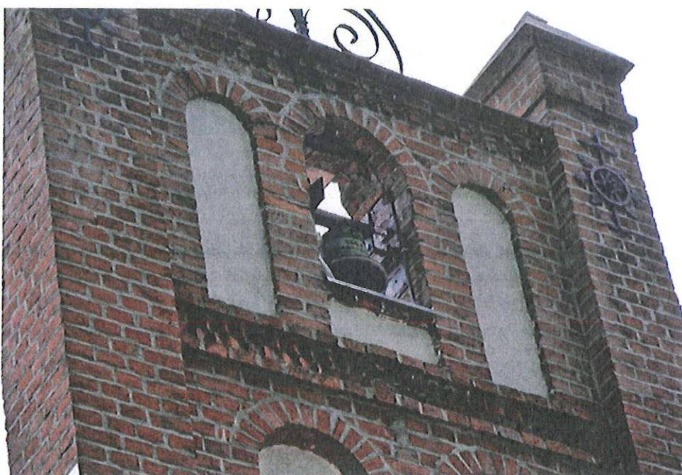
6. Ryzalit w elewacji frontowej (górna partia). Widoczne ubytki w licu cegieł.
