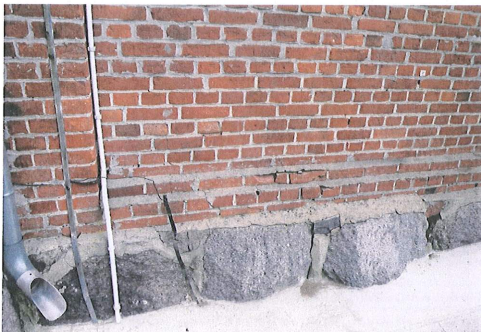
14. Fragment elewacji południowej (pierwsze przęsło). Widoczny stan zachowania ustrojów murowych.
