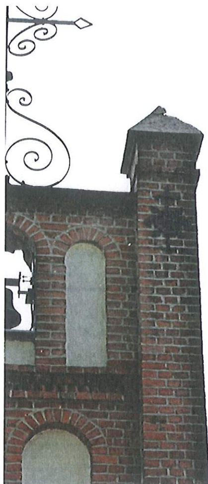
5. Ryzalit elewacji frontowej – strona prawa. Widoczny stan zachowania: zdegradowane spoiny i lico cegieł, ubytki w nakryciu pinakla.
