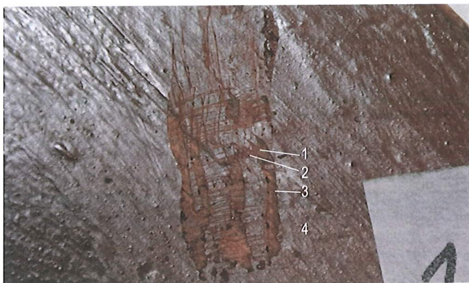
12. Policzek schodów (pkt 1). Widoczna stratygrafia warstw: 1-drewno, 2-warstwa malarska czerwono-brązowa, 3- warstwa malarska siena palona, 4- warstwa malarska umbra palona.
