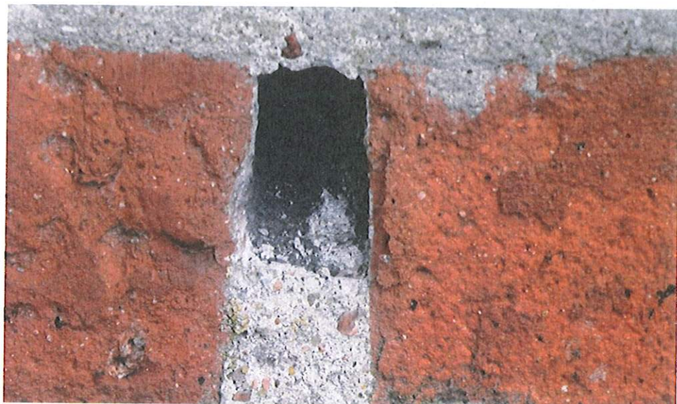
22. Elewacja południowa (punkt 6). Widoczna struktura muru z widoczną zaprawą z domieszka popiołu i spoiną (fugą) wapienno-piaskową
