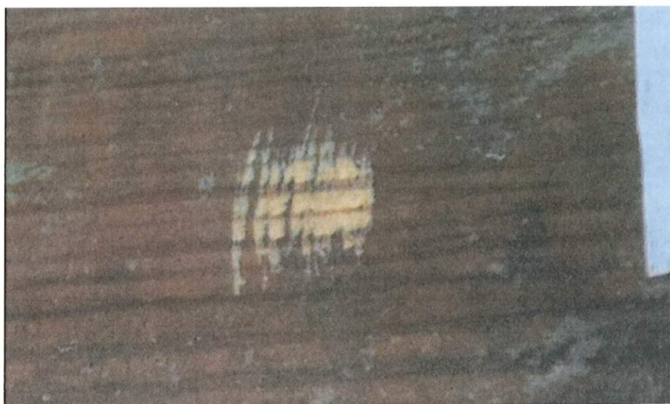
20. Płycina bariery emporu (pkt 7). Widoczna jest tylko jedna warstwa malarska. Jest pośredni dowód na nieautentyczność elementu.
