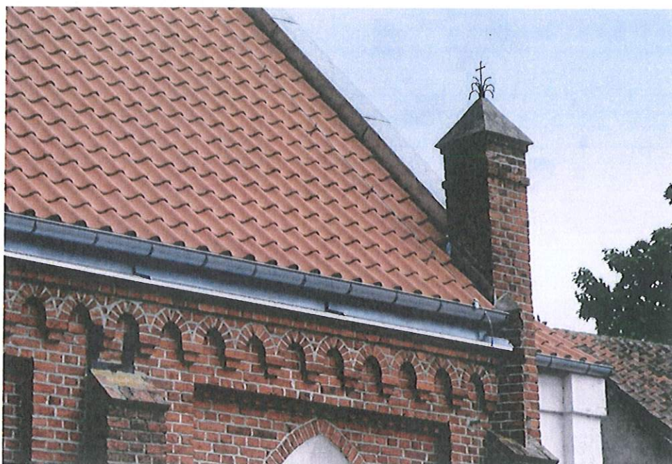
10. Fryz arkadowy i pinakiel ze wschodniej części elewacji południowej. Widoczny stan zachowania.
