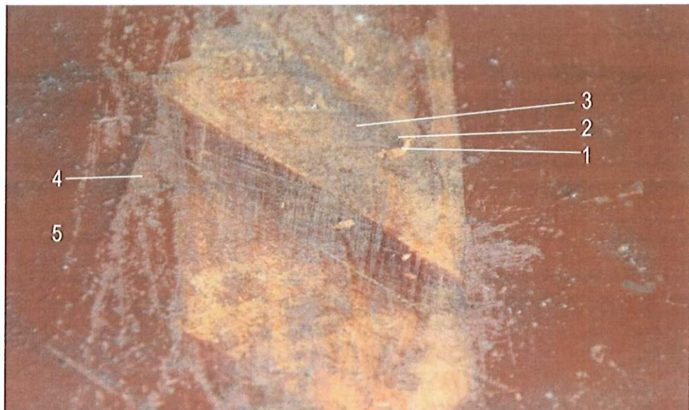
26. Zastrzał (pkt 17). Widoczna stratygrafia nawarstwień: 1-drewno, 2-warstwa malarska czerwonoróżowa, 3- warstwa malarska szara, 4- warstwa malarska rozbielona siena, 5 - warstwa malarska siena palona.
