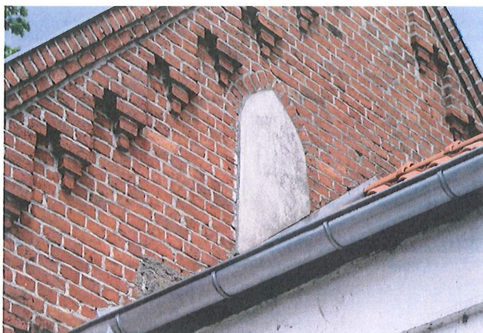
12. Szczyt elewacji wschodniej. Widoczne zamurowane okno z wyprawą wystającą ponad lico.
