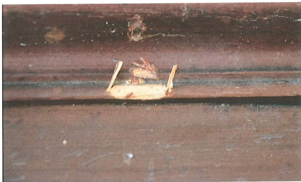
9. Fragment konstrukcji widziany od strony nawy – widoczny ubytek w profilu.
