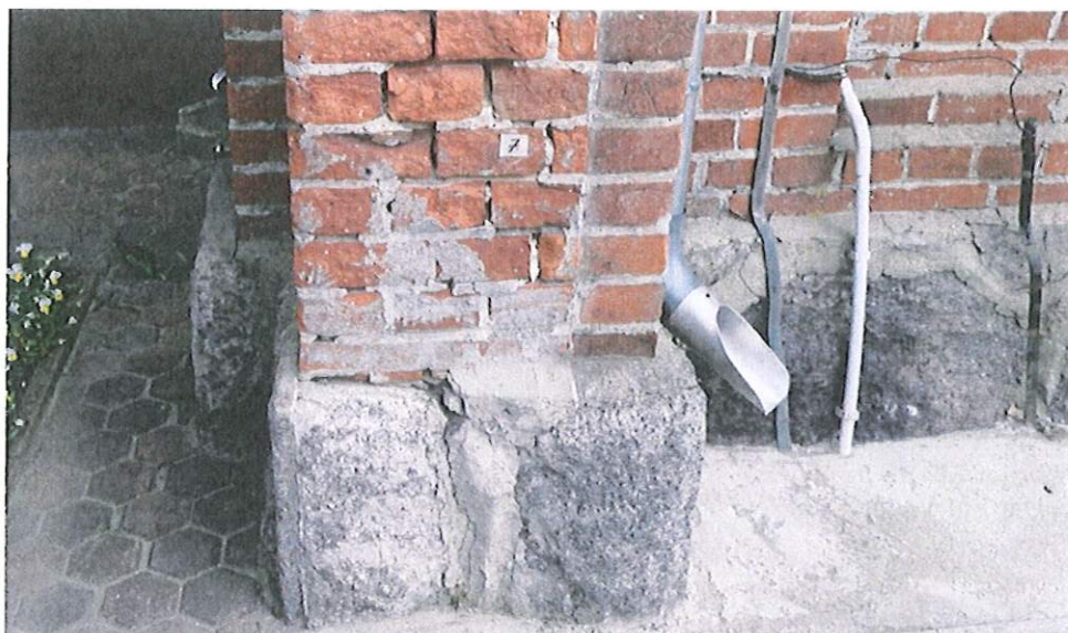
13. Podmurówka i dolna partia przypory skrajnej w elewacji południowej. Widoczny stan zachowania ustrojów murowych.
