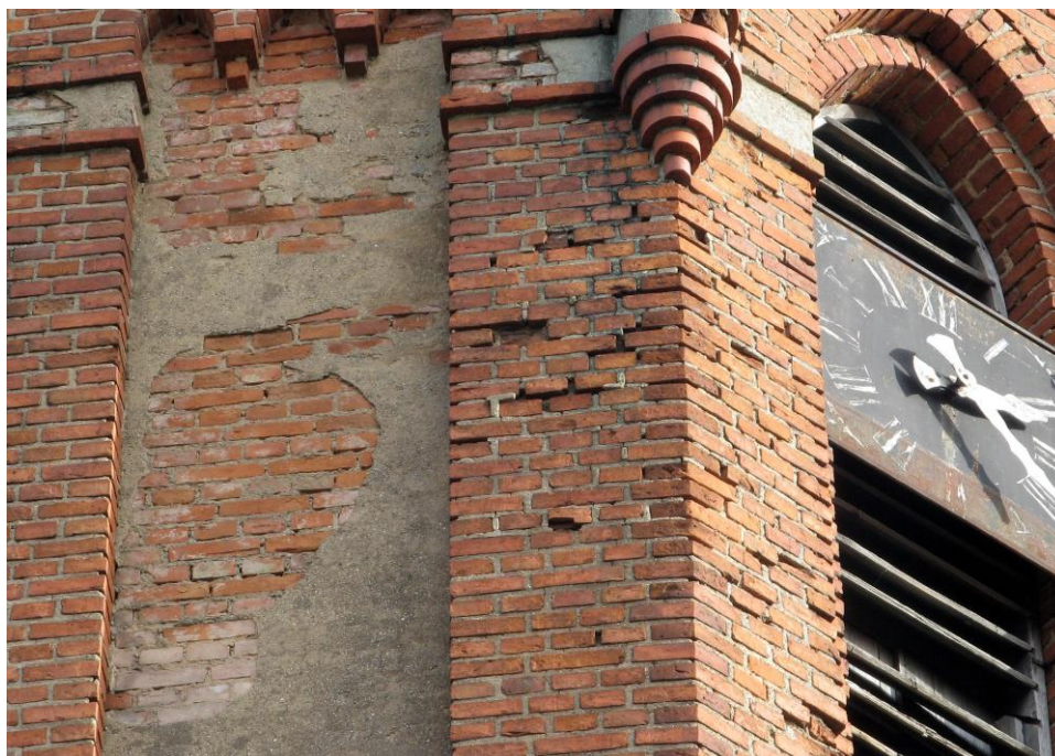
Widok zniszczonego tynku na wieży.
