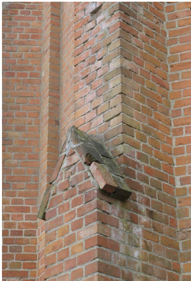
Widok zniszczeń na szkarpie wywołanych wypłukiwaniem soli
