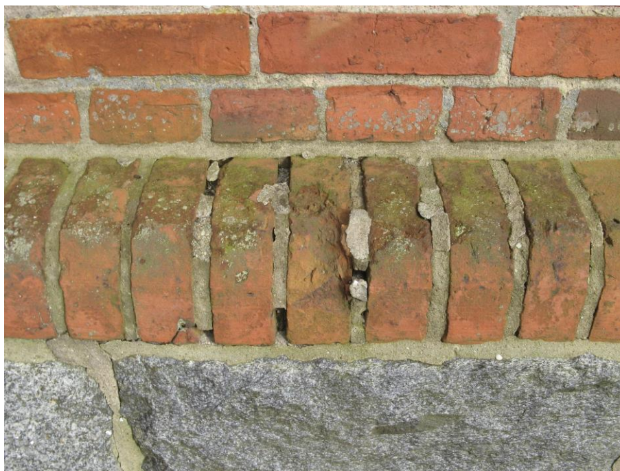
Widok porośniętej ceglanej pokrywy odsadzki cokołowej
