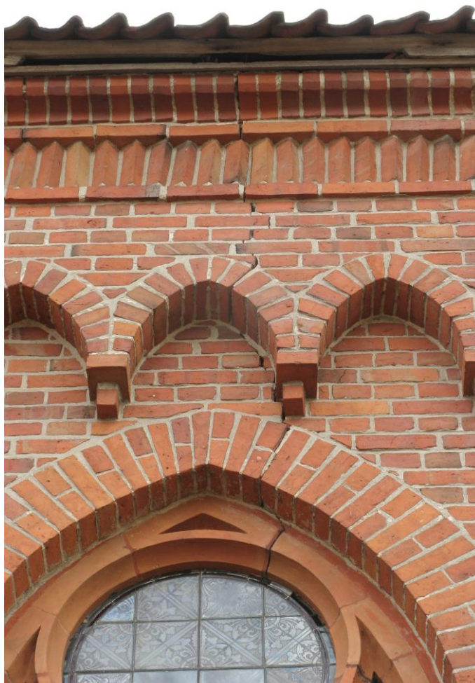
Widok pęknięcia w nadprożu okna
