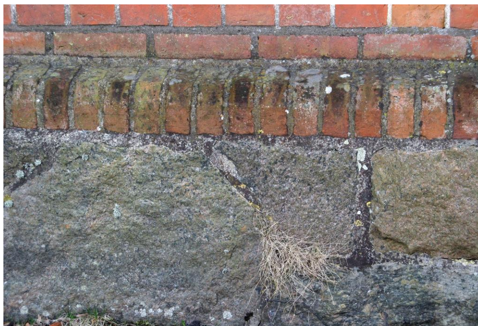
Widok cokołu porośniętego glonami
