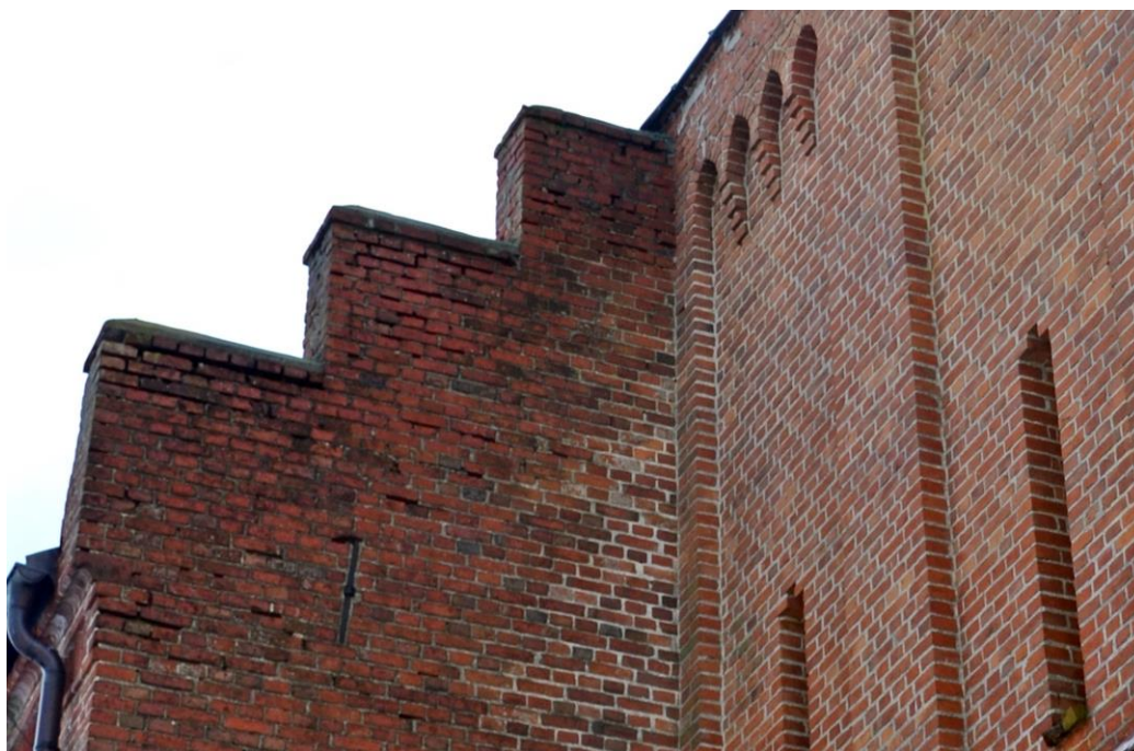
Fragment bocznego szczytu nawy od strony północnej, silne zawilgocenie i nawarstwienia glonów
