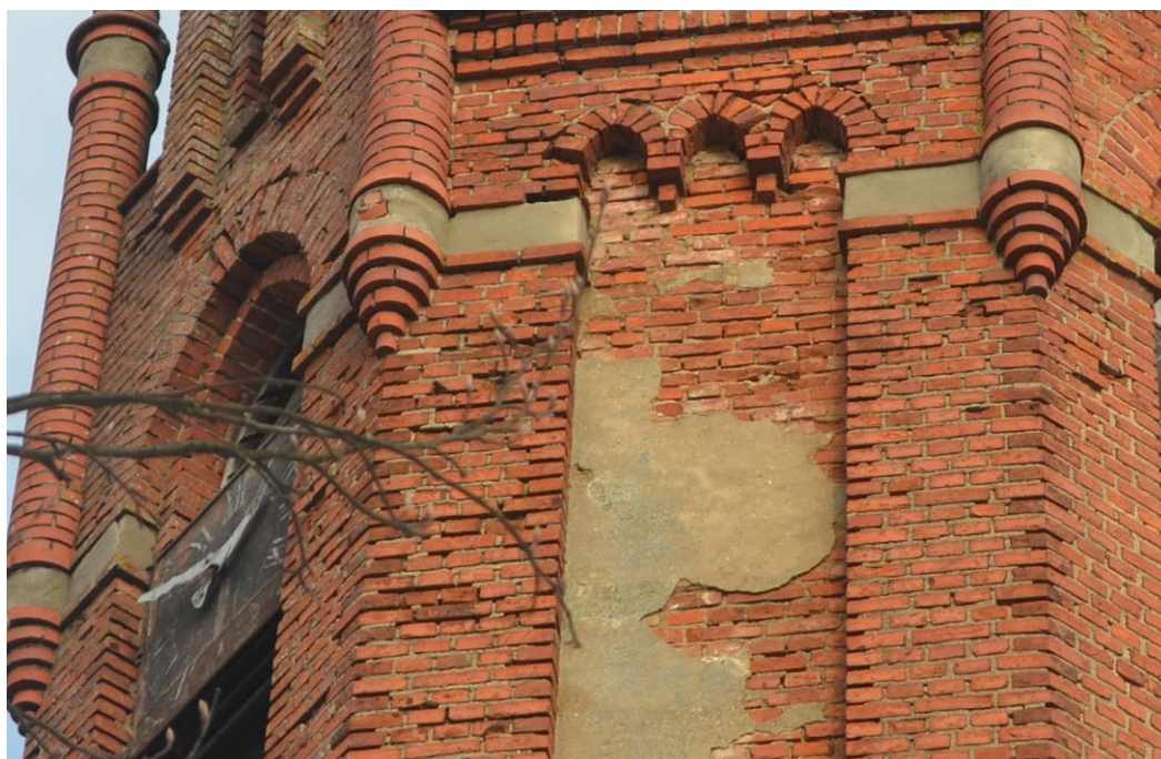
Widok uszkodzonych cegieł
