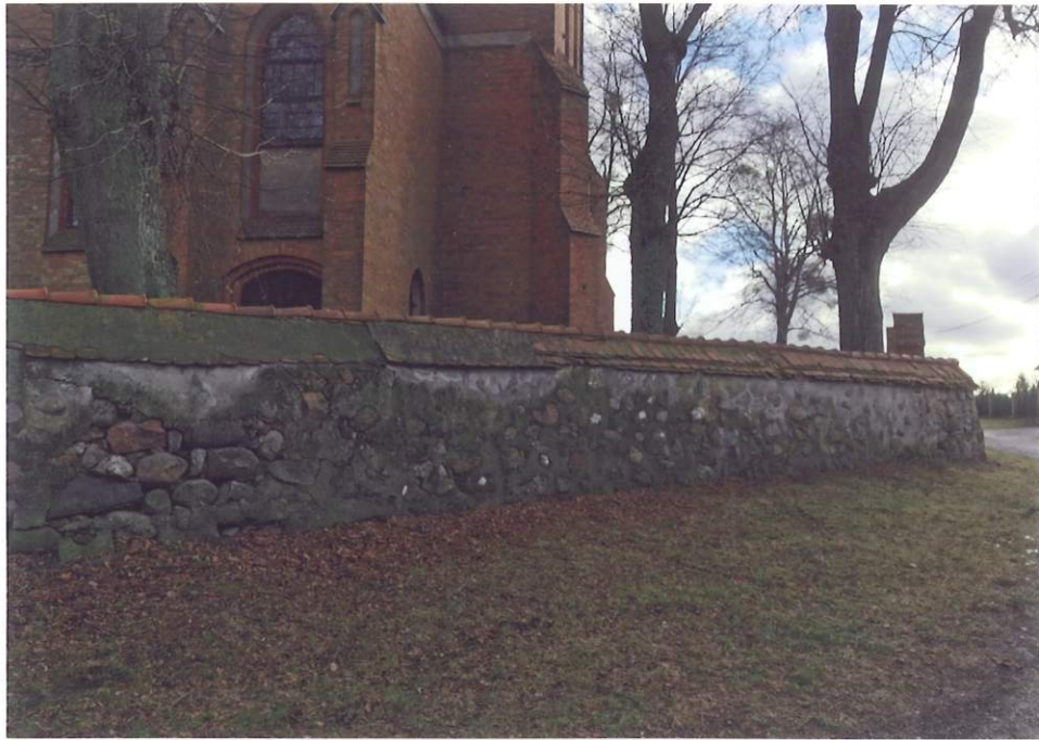
Fot 7. Mur od strony wschodniej widok ogólny
