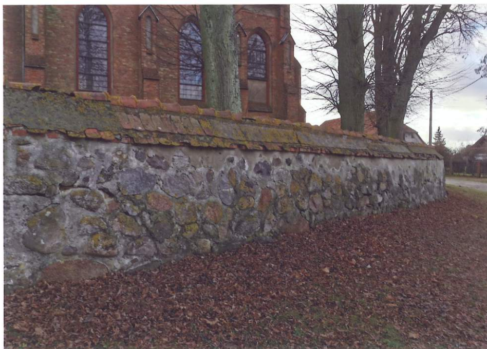
Fot 10. Mur od strony północnej widok ogólny
