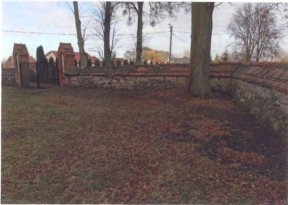
Fot 12. Mur od strony północnej-wschodniej widok ogólny
