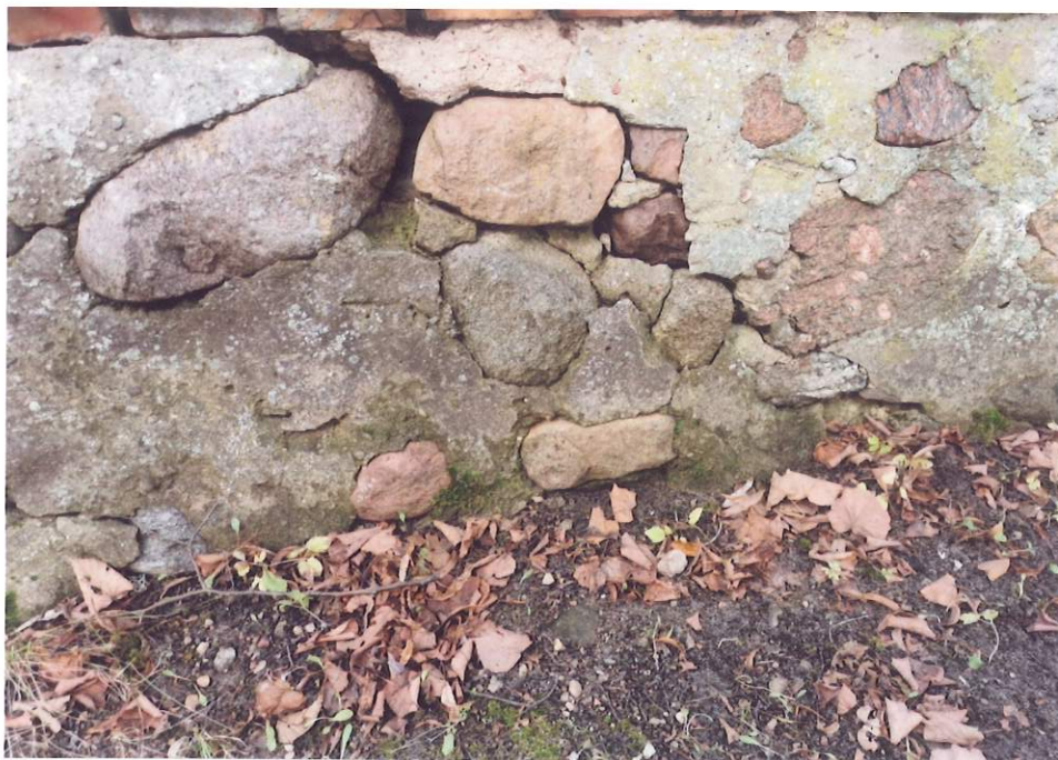
Fot 35. Ubytki zaprawy spajającej materiał kamienny, wtórne cementowe reparacje w formie szlichty
