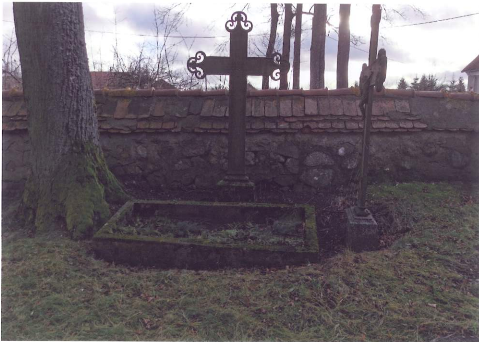
Fot 57 Stan zachowania nagrobki w sąsiedztwie muru
