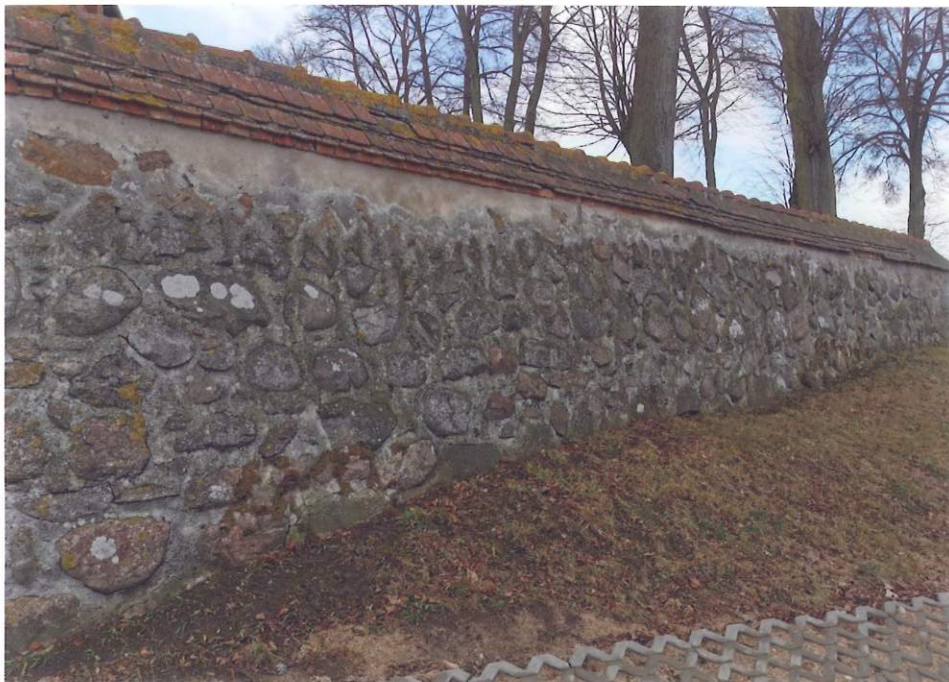
Fot 9. Mur od strony północno-wschodniej widok ogólny
