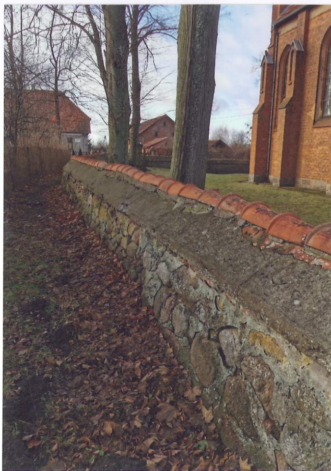
Fot 2. Mur od strony południowej widok ogólny
