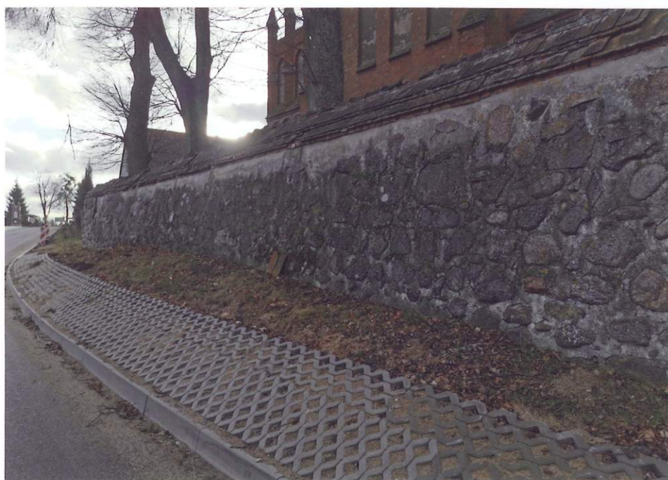
Fot 6. Mur od strony wschodniej widok ogólny
