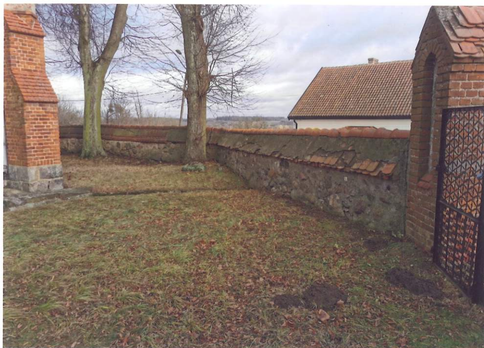
Fot 5. Mur od strony południowo-wschodniej widok ogólny
