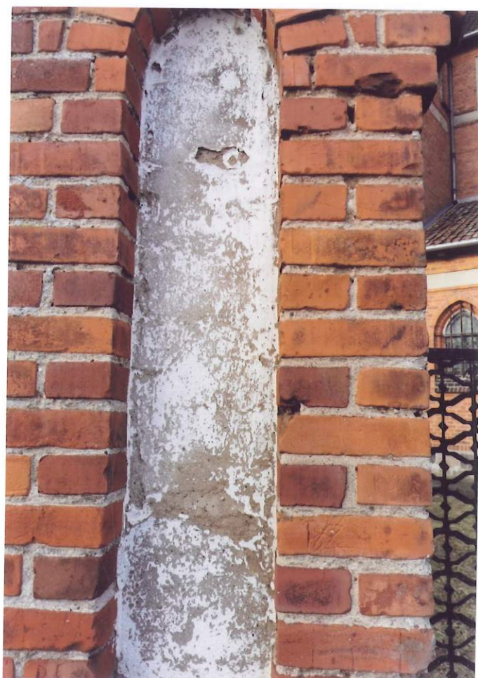
Fot 54 Stan zachowania wypraw tynkarskich blend
