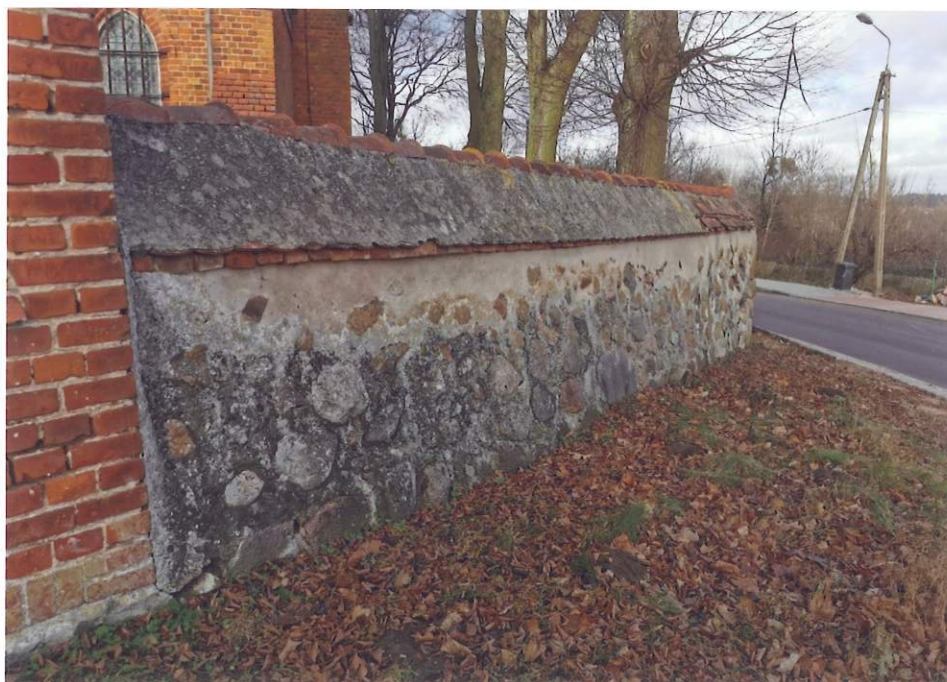
Fot 4. Mur od strony południowo-wschodniej widok ogólny
