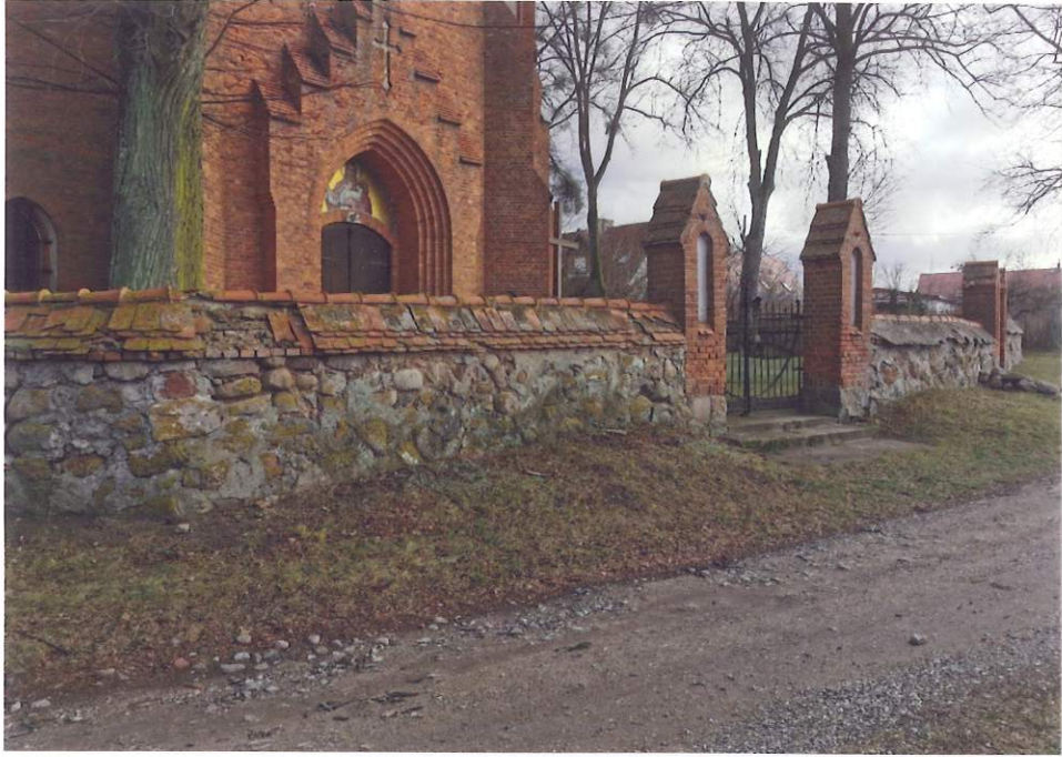
Fot 11. Mur od strony zachodniej widok ogólny
