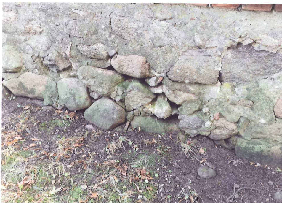
Fot 40 Wtórne szlichty cementowe
