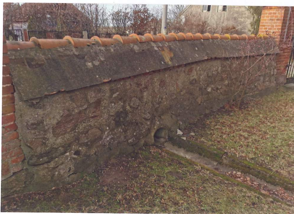
Fot 14. Mur od strony zachodniej widok ogólny
