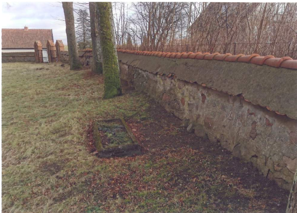
Fot 3. Mur od strony południowej widok ogólny
