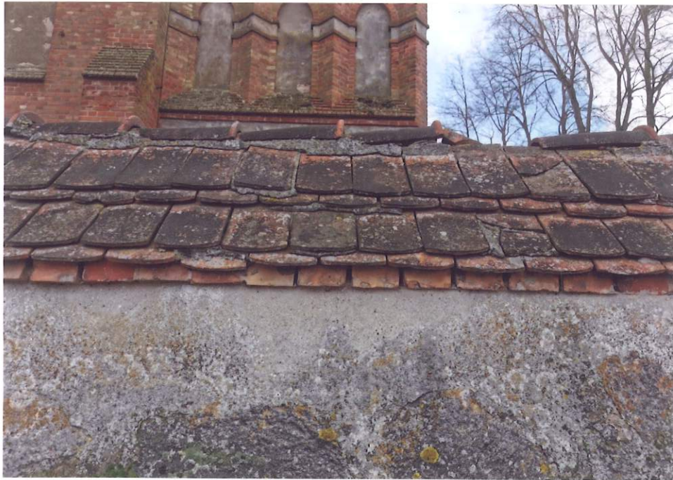
Fot 21. Historyczny układ ceramicznego pokrycia muru
