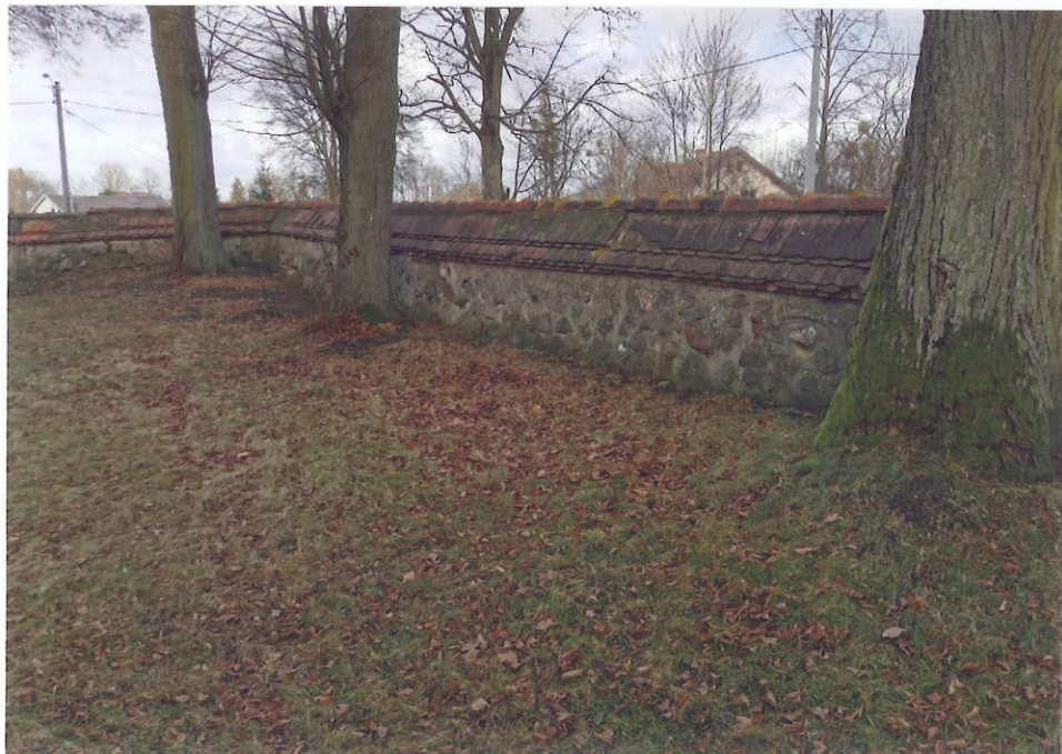
Fot 8. Mur od strony wschodniej widok ogólny
