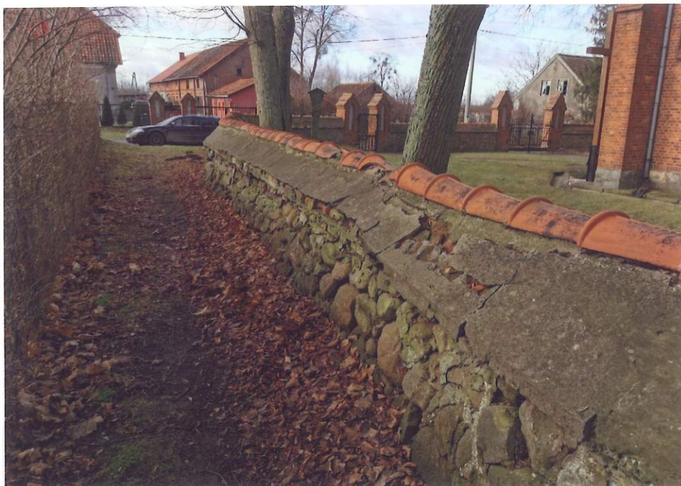
Fot 1. Mur od strony południowej widok ogólny
