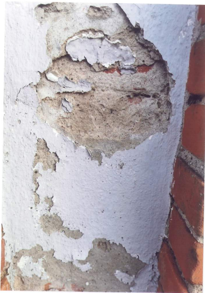
Fot 55 Stan zachowania wypraw tynkarskich blend
