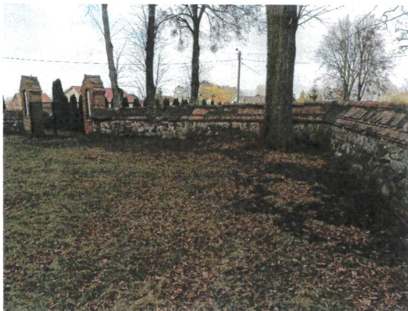
Fot. 12. Mur od strony północnej-wschodniej widok ogólny
