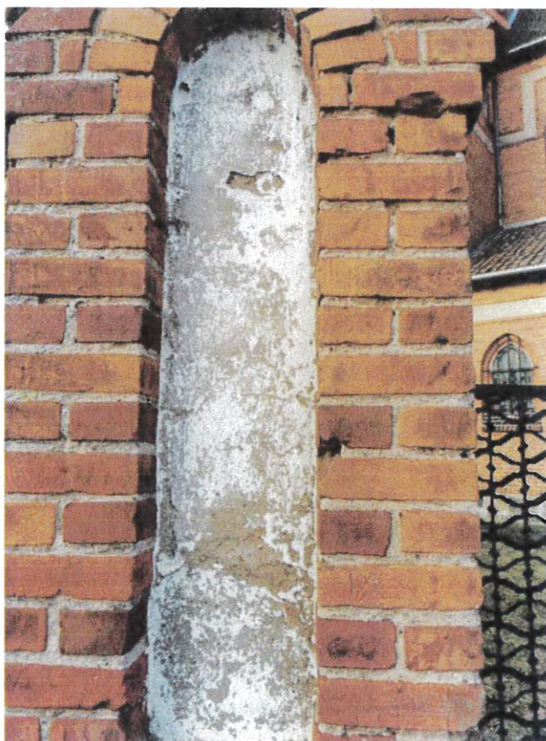
Fot. 54. Stan zachowania wypraw tynkarskich blend
