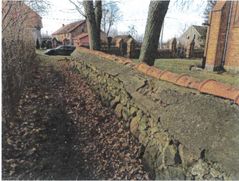
Fot. 1. Mur od strony południowej widok ogólny
