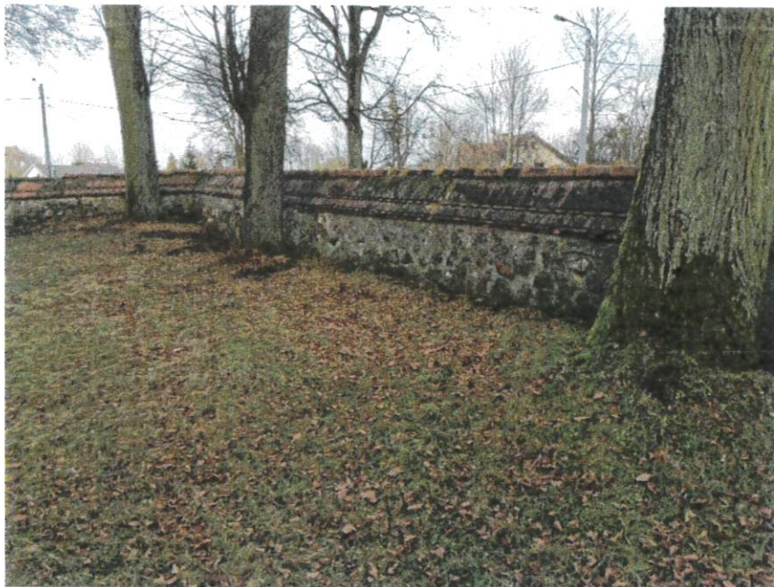
Fot. 8. Mur od strony wschodniej widok ogólny
