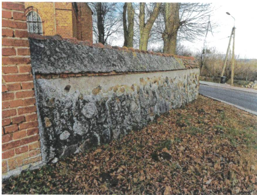
Fot. 4. Mur od strony południowo-wschodniej widok ogólny
