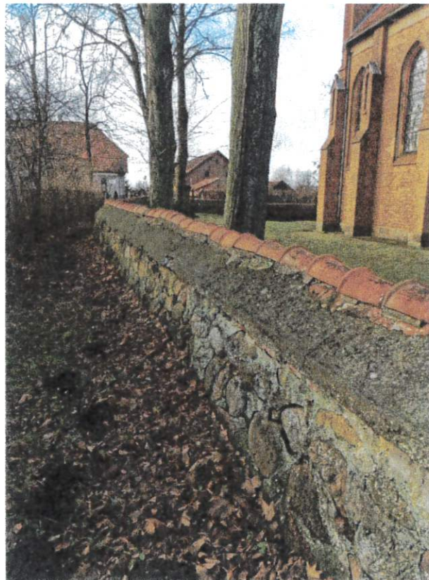
Fot. 2. Mur od strony południowej widok ogólny
