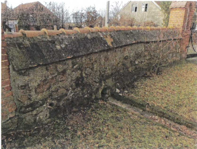
Fot. 14. Mur od strony zachodniej widok ogólny
