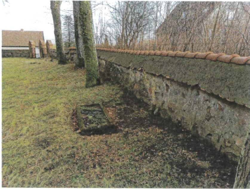
Fot. 3. Mur od strony południowej widok ogólny
