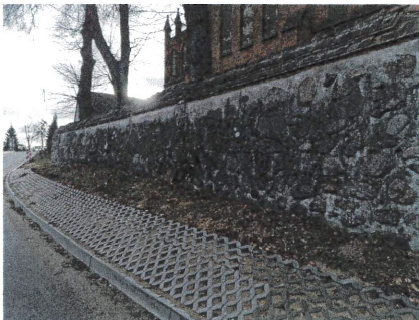
Fot. 6. Mur od strony wschodniej widok ogólny
