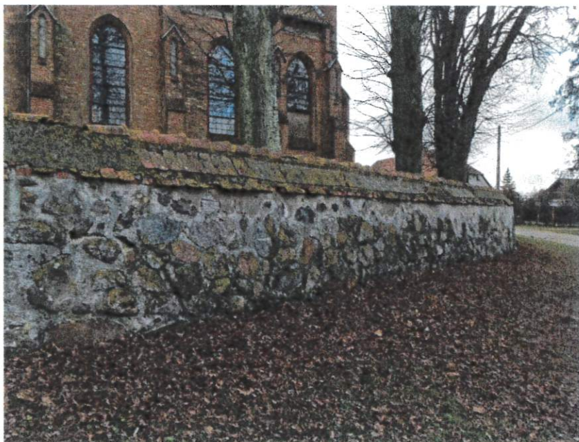
Fot. 10. Mur od strony północnej widok ogólny
