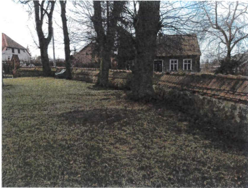
Fot. 13. Mur od strony północnej i północno-zachodniej widok ogólny
