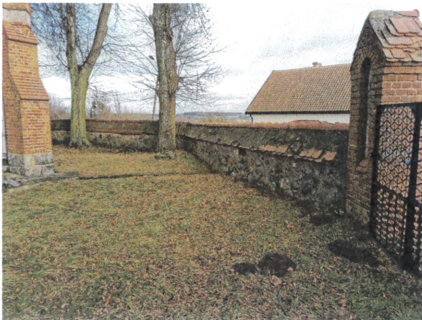
Fot. 5. Mur od strony południowo-wschodniej widok ogólny
