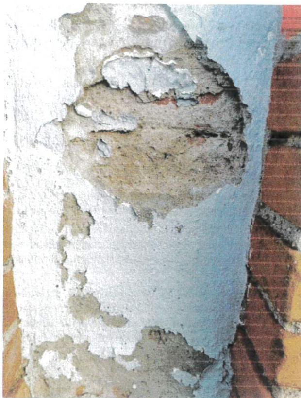
Fot. 55. Stan zachowania wypraw tynkarskich blend
