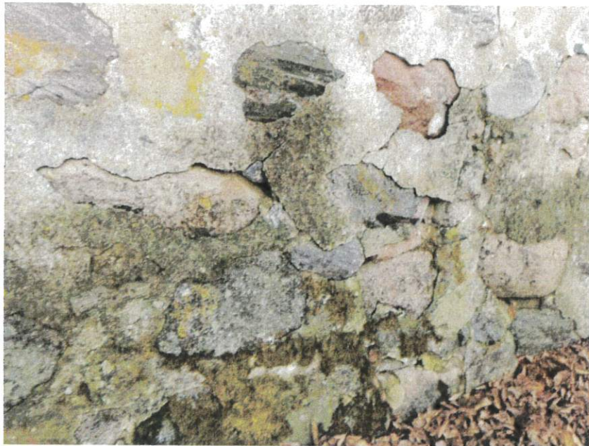
Fot. 40. Wtórne szlichty cementowe
