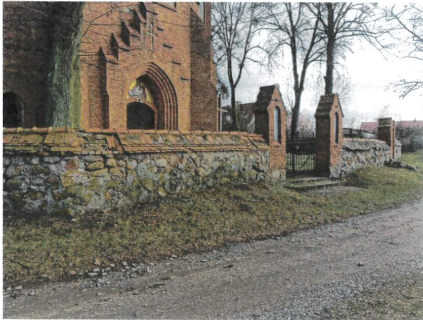
Fot. 11. Mur od strony zachodniej widok ogólny
