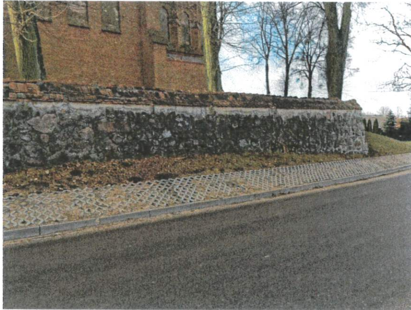
Fot. 7. Mur od strony wschodniej widok ogólny
