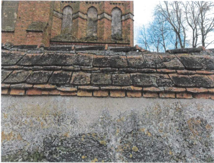
Fot. 21. Historyczny układ ceramicznego pokrycia muru
