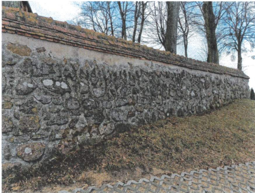
Fot. 9. Mur od strony północno-wschodniej widok ogólny
