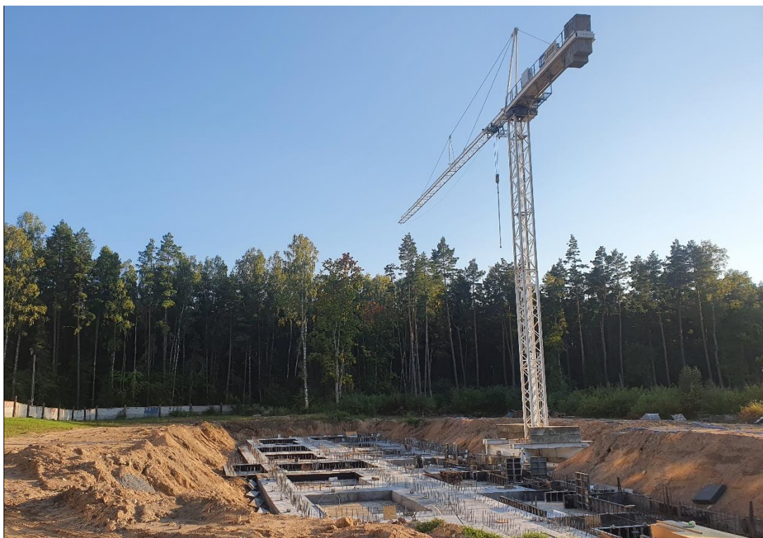
Fot. 1 Widok na tereny w trakcie budowy (fot. własna)
