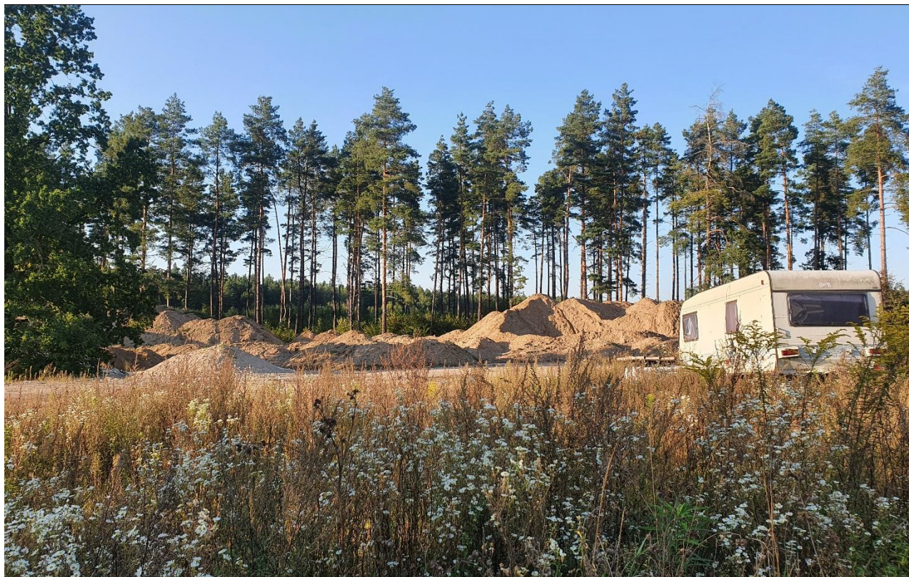
Fot. 4 Nasypy budowlane na terenie opracowania (fot. własna)
