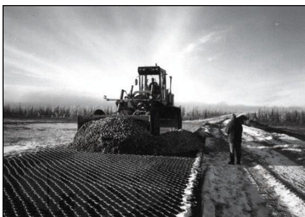
Rys. 6. Zасыpywanie kruszywem komórek geosiatki за помощью ровниarki
