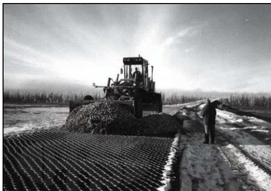
Rys. 8. Zasypywanie kruszywem komórek geosiatki za pomocą równiarki
